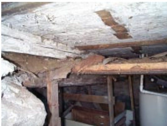
Malingsspor i kjellerens himling vitner om gjenbruk.
