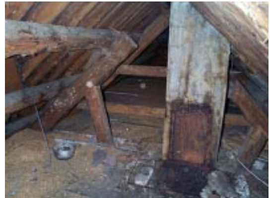
Søndre pipeløp på loft. Fotos 2000.
