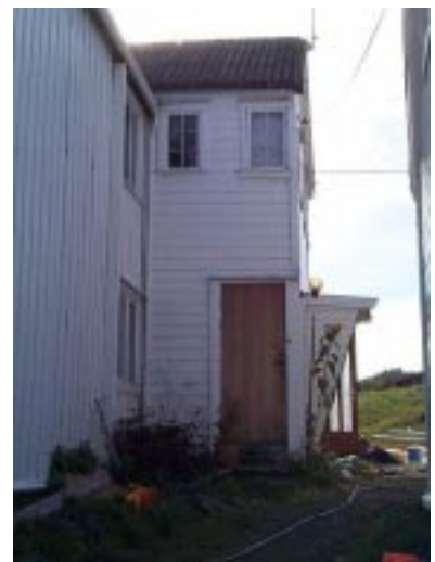
Inngangsparti sett fra N.
