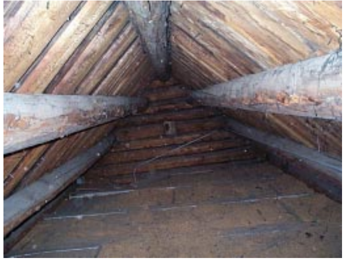
Sørlige del av loft. Fotos 2000.
