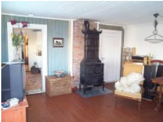
Etasjeovn og røykrør i stue mot nord 2.etg.
