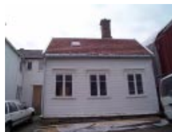
Kårhuset under og etter istandsetting. Foto 1999 /2000.
