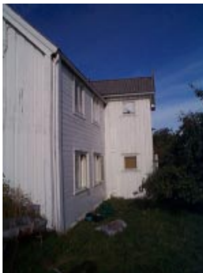
Tilbygget mot øst har vært glassveranda.
