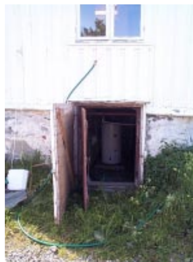
Inngang til kjelleren mot nord. Fotos 1999.
