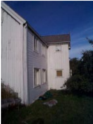
Tidligere glassveranda sett fra S.
